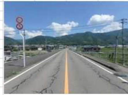
写真2 全景(終点→起点)
