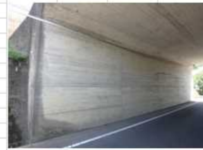
写真6 下部工全景(P1橋台)
