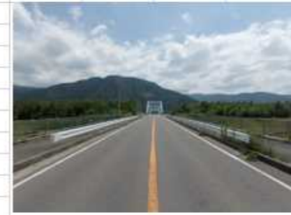
写真2 全景(終点→起点)
